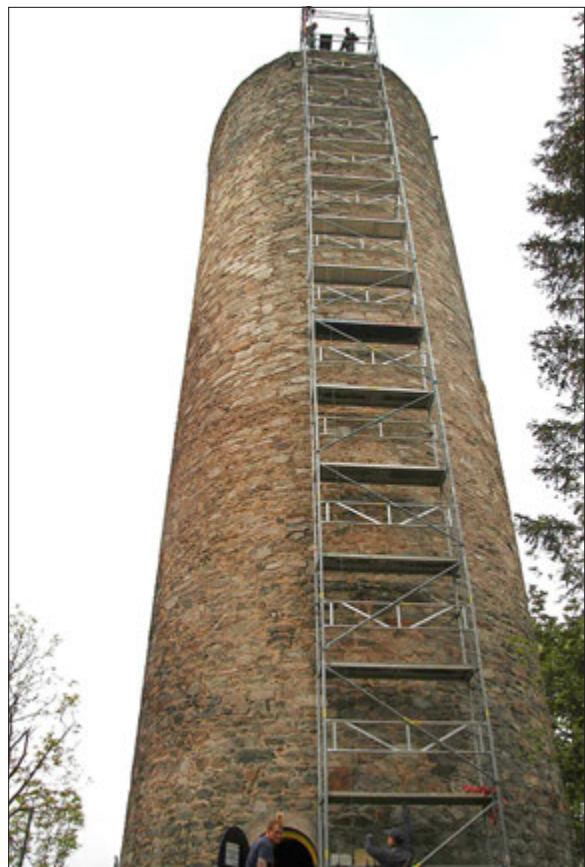
Gerüst am „Alten Turm“
