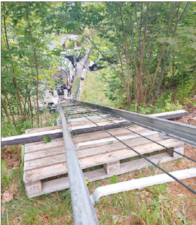
Transport des Gussasphalts mit Schrägaufzug
